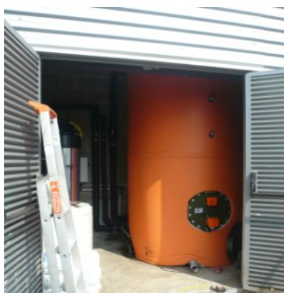
Installation du nouveau ballon d'eau chaude par l'entreprise TCPE courant juillet 2014.
