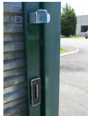
Pose d'une serrure avec gâche
